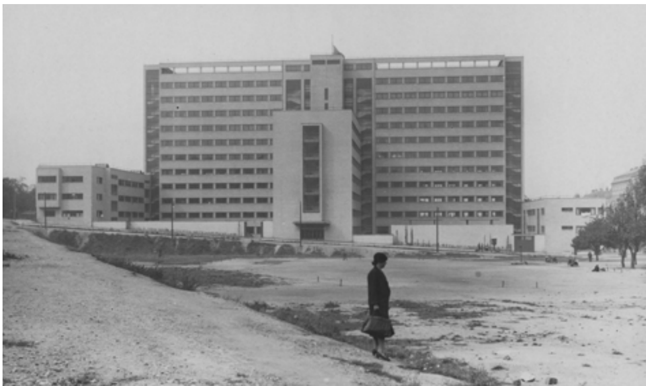
Architektury inspirovaly kancelářské budovy v Berlíně, Stuttgartu nebo Rotterdamu
